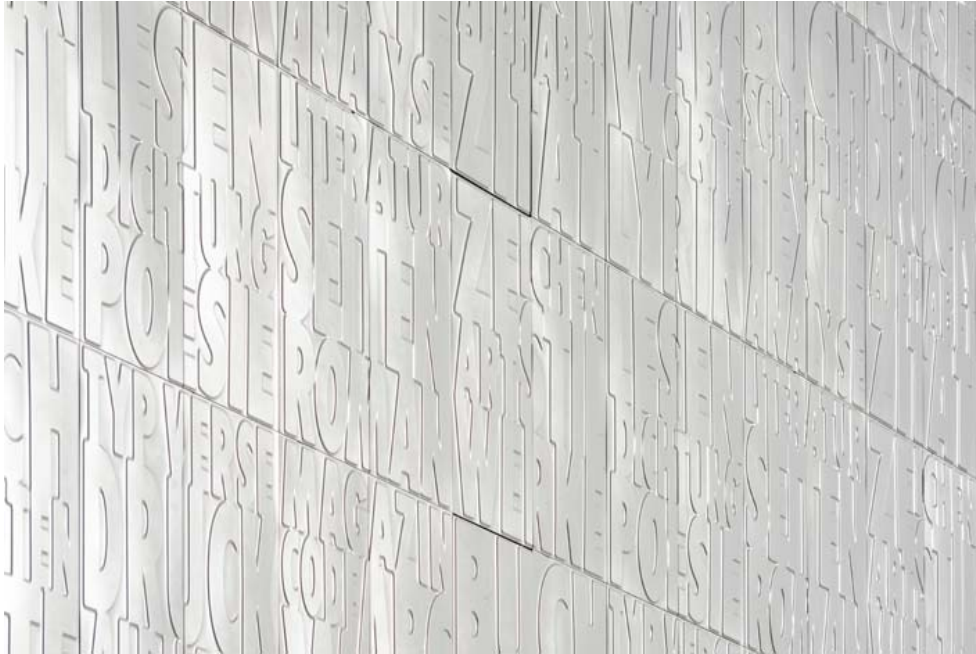
HKP_SuUB_IMGP5584_kl.jpg Minimaler Reinigungsaufwand trotz dreidimensional geprägter, weißer Fläche: Duraflon® verfügt über einen materialimmanenten Easy-to-Clean-Effekt.
